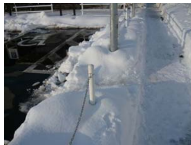
駐車場と歩道がせっかく除雪されているのに、境界部分に雪がたまっていきます
