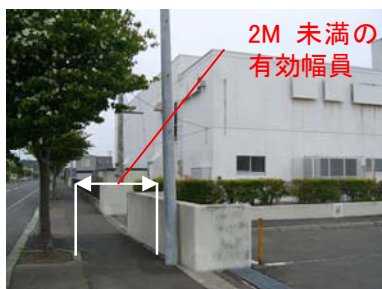
植樹柵部分では 2m未満の幅員の歩道があります
