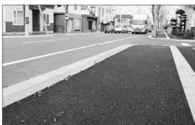
バリアフリー特定道路整備事業（5,040万円）歩道段差解消、点字ブロック敷設など（島松中通）
