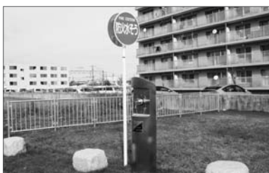
防火水槽整備事業（1,192万円）耐震性防火水槽1基設置（相生町）
