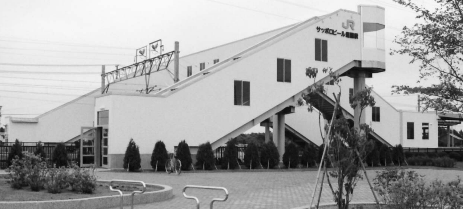
▲平成2 (1990) 年7月に開業したサッポロビール庭園駅
