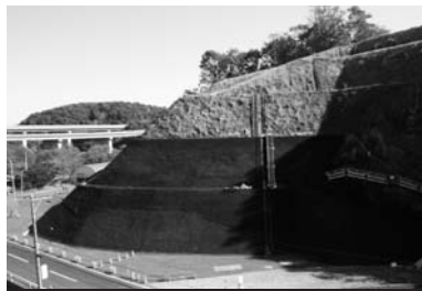
⑥ 落石防止対策事業（6,110万円）島松沢で落石防止対策を行いました
