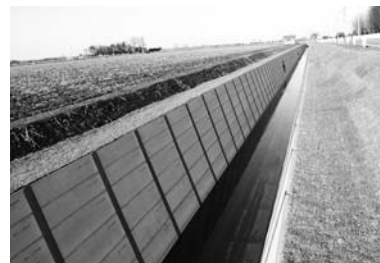
④ 西3線幹線排水路改修事業（1億6,192万円）市道西3線沿いの排水路を改修しました
