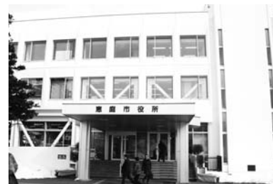
①庁舎改修事業 (3億9,819万円) 市役所庁舎の耐震改修工事などを行いました
