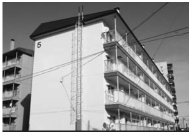
⑦ 旭団地改修事業（4,061万円）市営住宅旭団地の屋根・外壁改修工事を行いました
