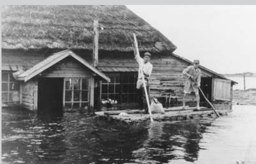
昭和37（1962）年8月、台風9号と続く10号の大雨で、漁太・林田・北島は半月以上水浸しとなった。被災者は島松公民館の和室に避難。住居・農業・土木被害の総額は3億円に上った。写真は半分水没した自宅をイカダで見回る住人。
