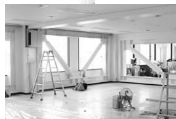
▲市庁舎も耐震改修を行いました
