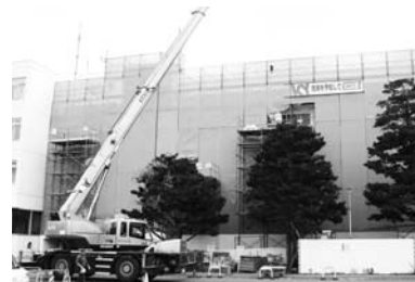
① 庁舎改修事業 市役所庁舎の耐震改修などを行いました
