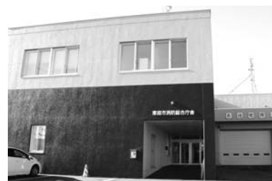
⑦ 消防庁舎整備事業 消防庁舎の増改築工事を行いました
