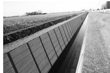
④ 西3線幹線排水路改修事業 市道西3線沿いの排水路を改修しました
