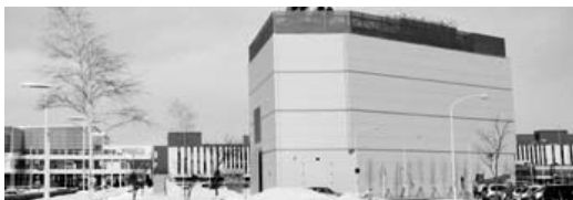
雪氷熱（千歳市） 空港ターミナルビルへの冷熱供給 （貯雪量 12 万m 3 ）
