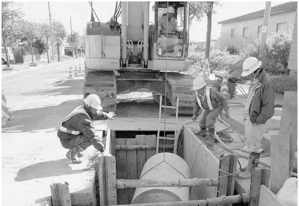
下水管敷設工事
