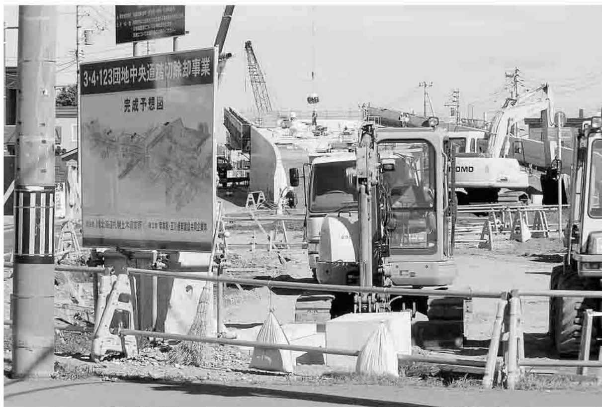
団地中央通り(高架工事)
