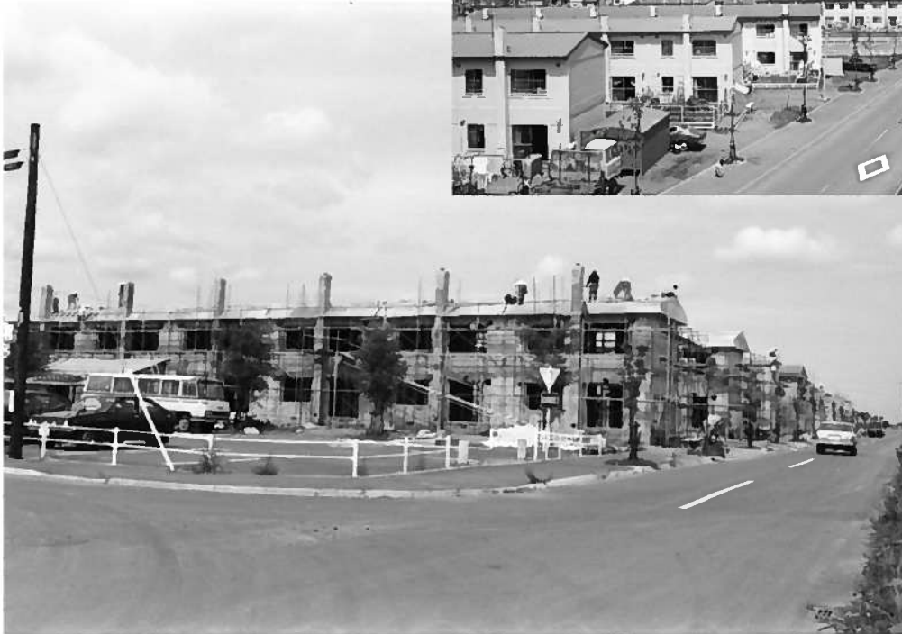
1976.9 柏陽団地建設中の様子
