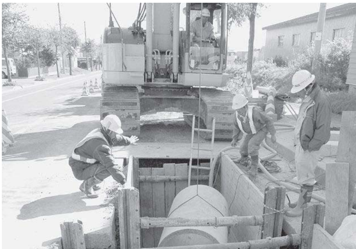
下水管敷設工事
