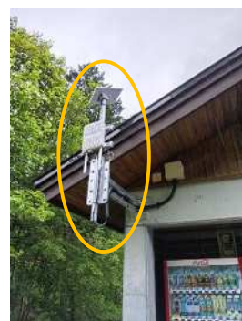
写真 1 スターリンク設備設置状況
